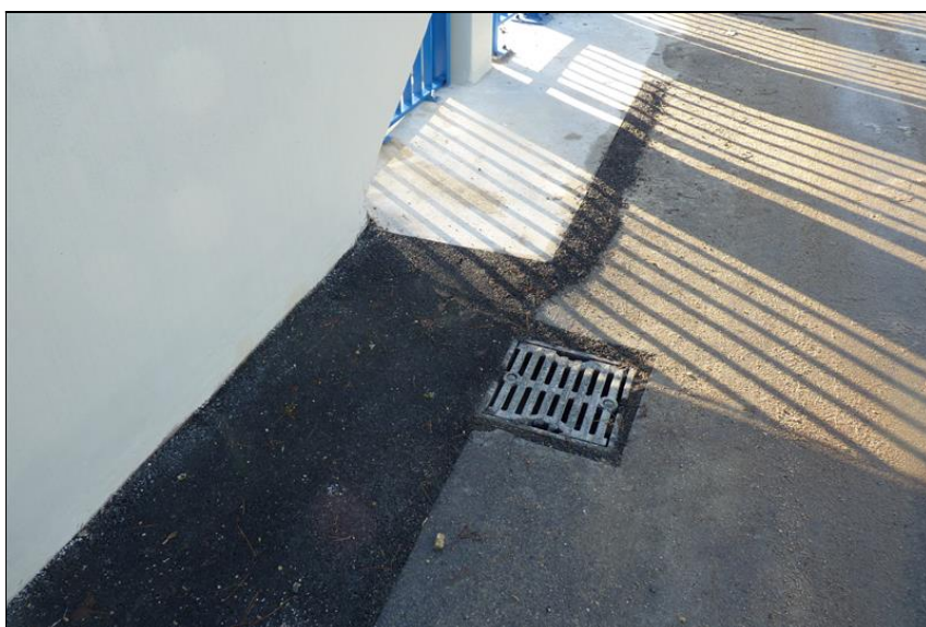
Mostní odvodňovač na pravé straně na konci mostu
