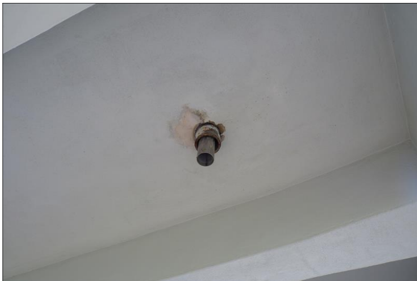
Detail svodu odvodňovače
