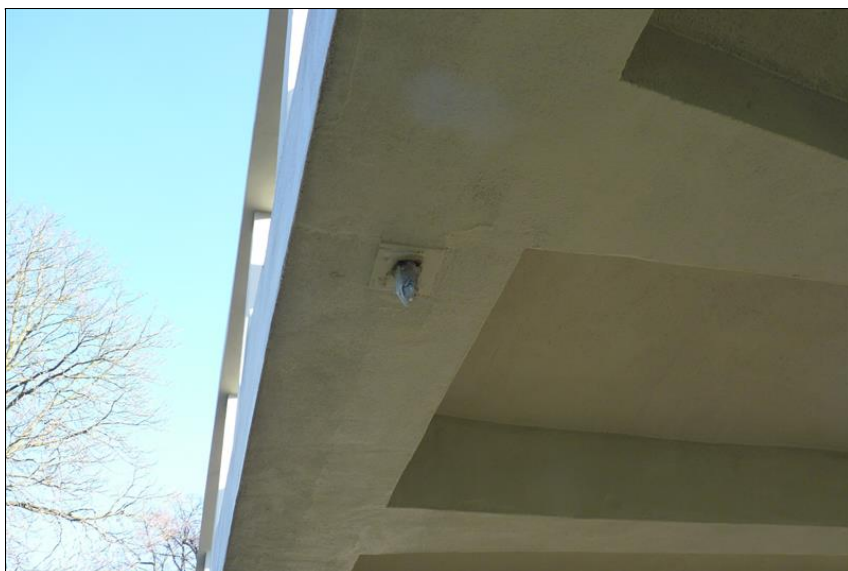
Detail kotvy ocelového táhla mezi obloukem a deskou mostovky
